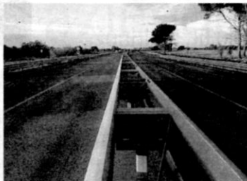
L'ARTERIA STRADALE Un tratto della strada «Regionale 8» nella parte già realizzata. Si attende da quasi trent'anni il completamento dell'importante opera [Massimino foto]
